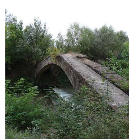
Pont aqueduc de la Canaü - 2ème moitié XVIe
