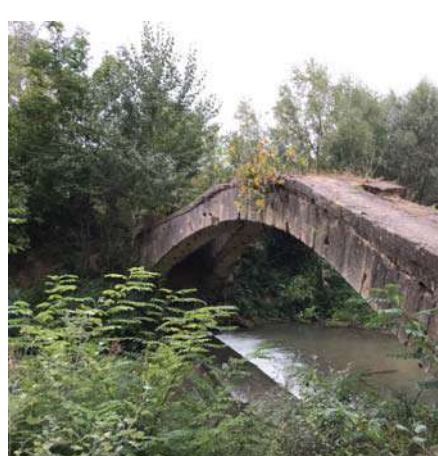
Pont acqueduc de la Canaù
