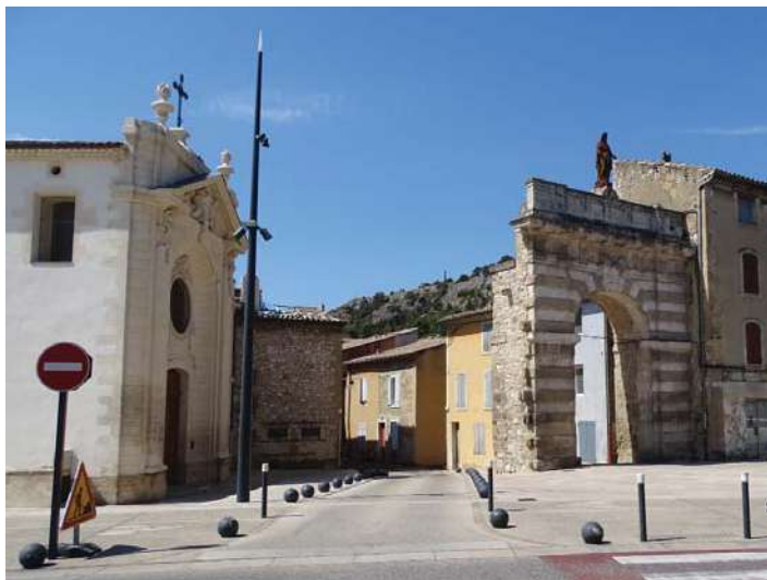
Chapelle de l'ancien Hôpital - XVIIIe / Porte d'Avignon - XVIIIe
